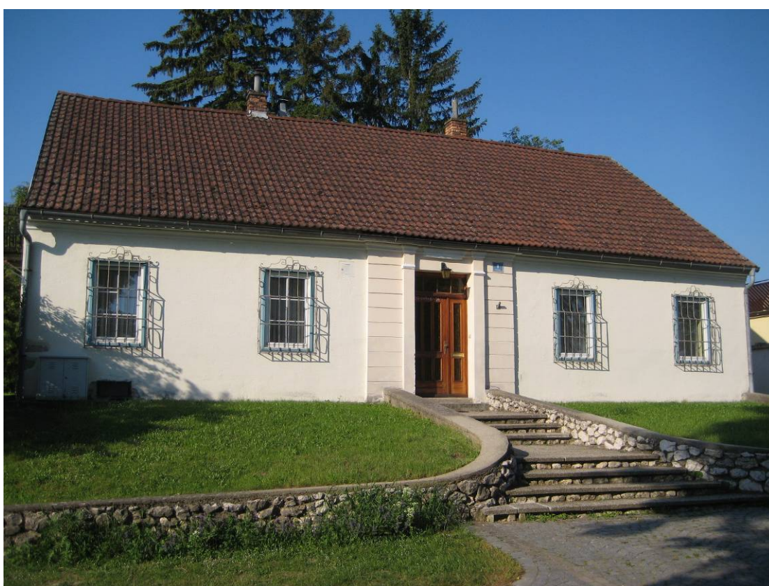
Am Standort des alten Pfarrhofes in Würnitz
